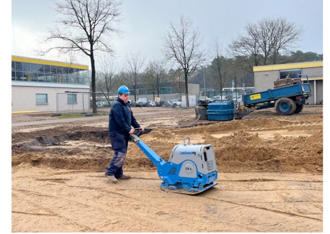
Grondwerker Robert verdicht de grond met een 6-tons trilplaat.
