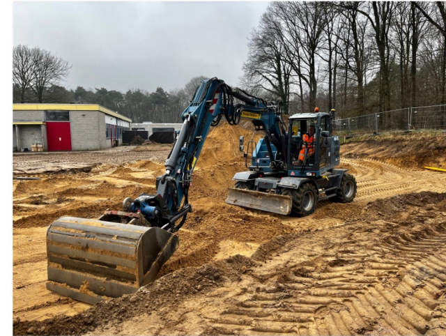
Kraanmachinist Geert-Jan van Voorst verplaatst het zand.
